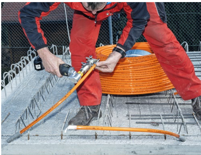
Installation, Funktionsüberprüfung und Anschluss der Leitungen.
