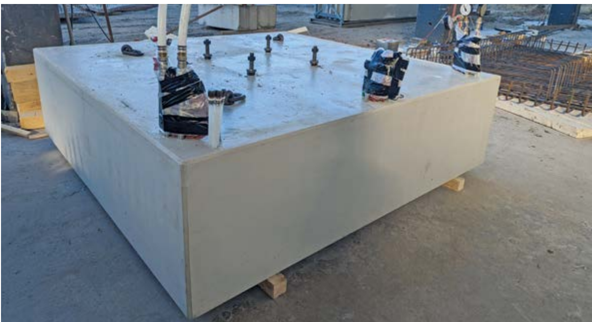
Vorgefertigter Fundamentblock für die Säule.
