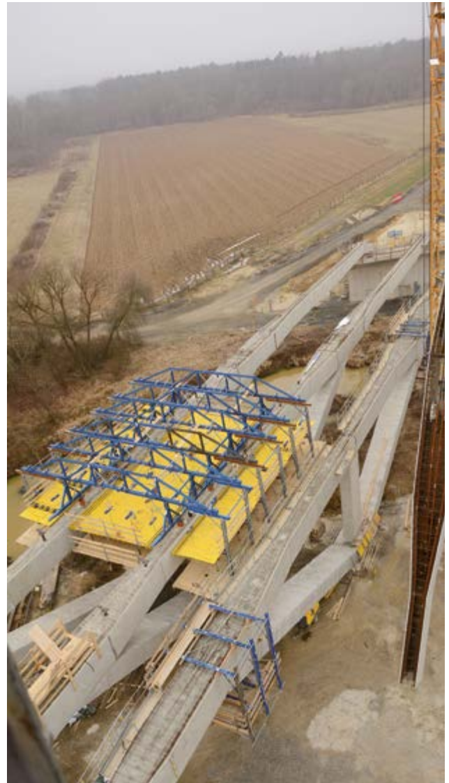
Die Fahrbahnplatte wird mit einem Schalungswagen auf den vier Brückenträgern erstellt.
