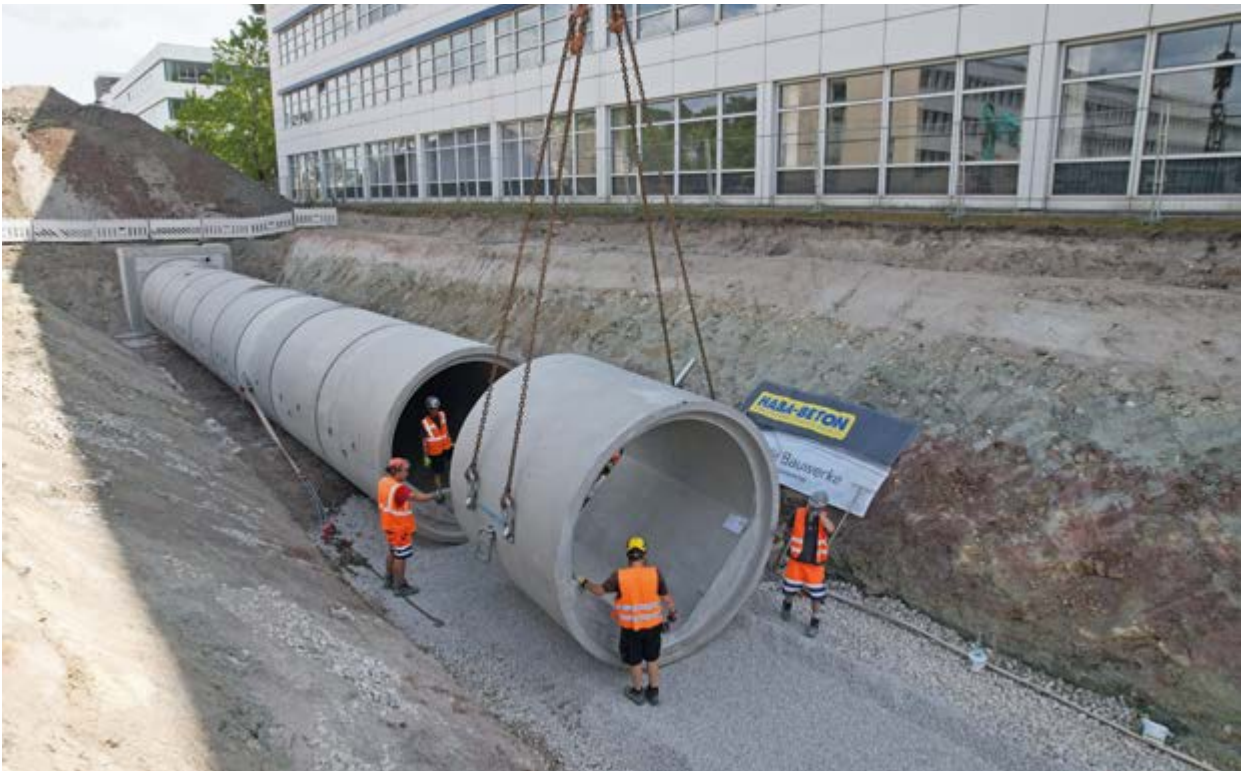
Die Drachenprofile werden auf der vorbereiteten Bettung verlegt.
