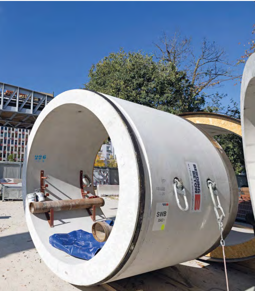
Insgesamt lieferte Berding Beton für die Baumaßnahme 315 Stahlbeton-vortriebsrohre mit je 11 t Gewicht.
