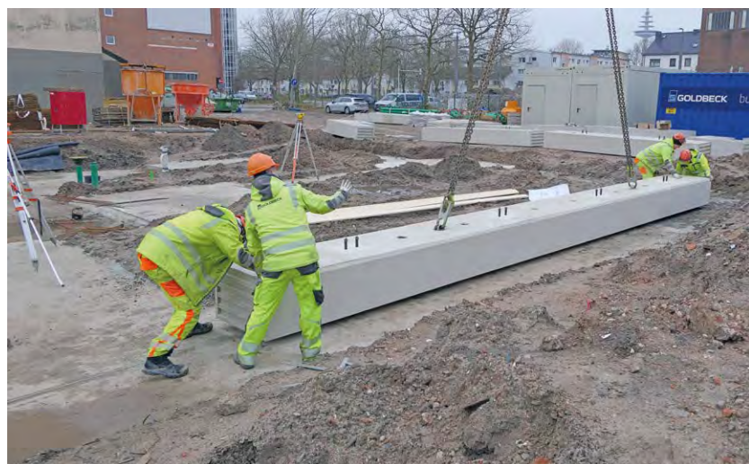
Mit den neuen BFT-Fundamenten will GOLDBECK nun auch das Bauen unterhalb der Geländeoberkante standardisieren.
