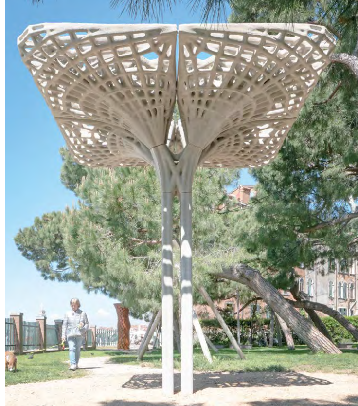
Der Marinaressa Coral Tree wurde für eine Ausstellung auf der Architekturbiennale 2023 in Venedig gebaut. Der Prototyp entstand im Rahmen eines Forschungsprojekts zur nachhaltigen Herstellung leichter Betonbauteile mittels abfallfreier Sandschalungen.
