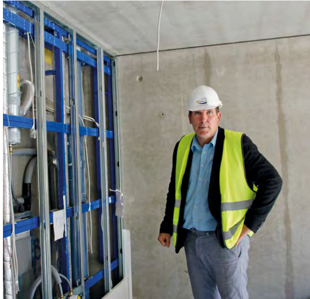
Henry Götze, Abteilungsleiter Technik der Wohnungsgenossenschaft „Carl Zeiss“ eG, auf der Baustelle.
