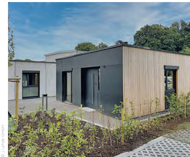
Individuell, robust und nachhaltig – die Prototypen der Lehde-Cubes, die am Firmengelände in Soest besichtigt werden können.
