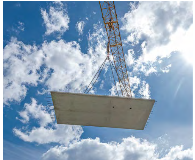
Bauteilaktivierung neu gedacht: Die Kirchdorfer Gruppe zeigt mit vorgefertigten Klimadecken, wie Beton zum effizienten Energiespeicher wird.
