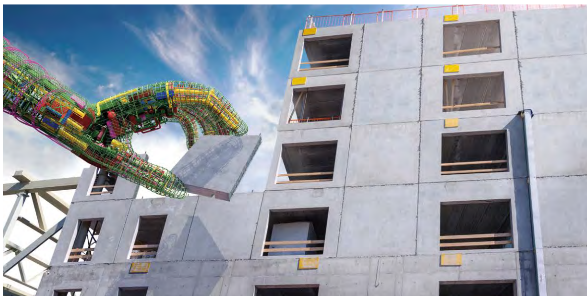
Digitalisierung und Robotik heben das serielle Bauen auf ein neues Level.
