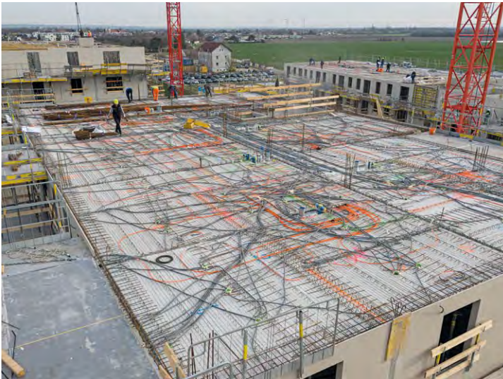
Bauteilaktivierung neu gedacht: Die Kirchdorfer Gruppe zeigt mit vorgefertigten Klimadecken, wie Beton zum effizienten Energiespeicher wird.
