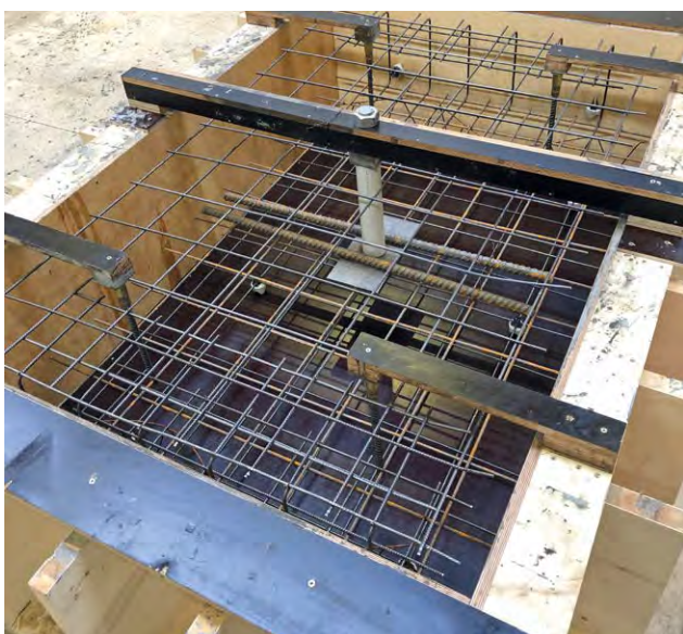
Flachstahlanker in der Schalung der Prüfplatte.
