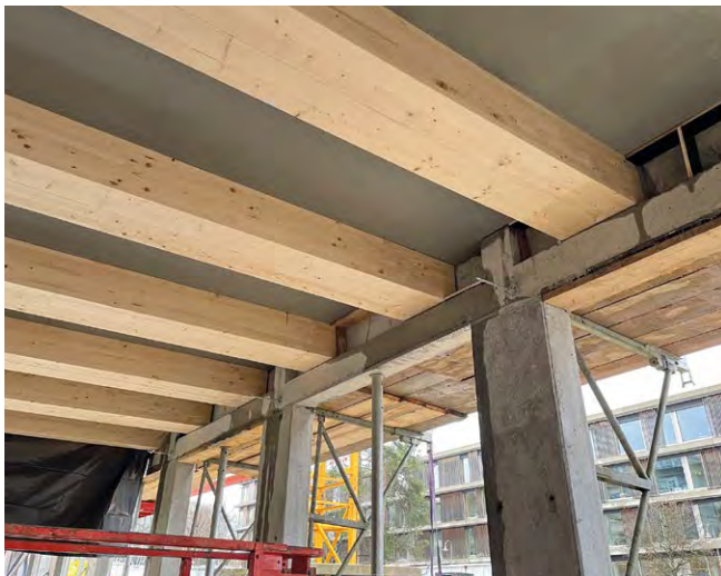
Montierte Holz-Beton-Verbunddecken auf der Baustelle.
