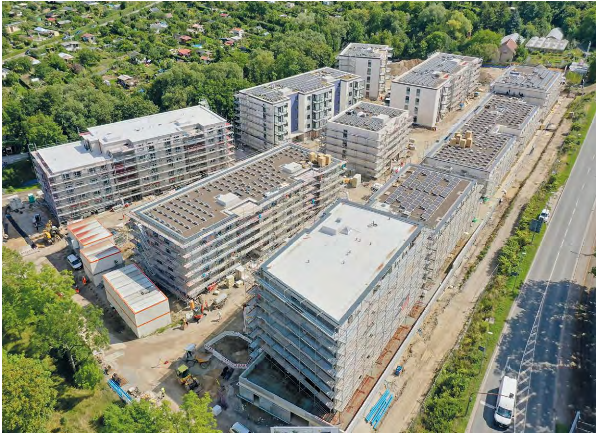
Das Wohnquartier „Erlenhöfe“ in Jena entstand im Zuge der GdW-Rahmenvereinbarung.
