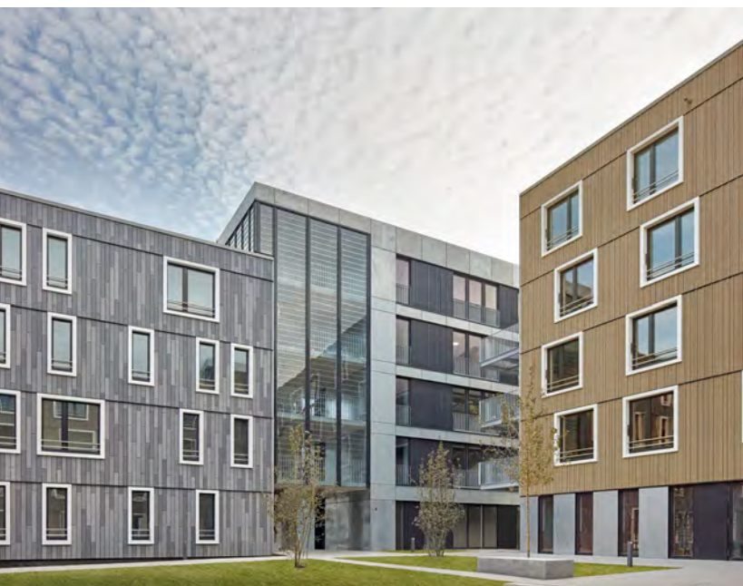
Fertiggestellter Gebäudekomplex mit Spannbeton-Fertigdecken.
