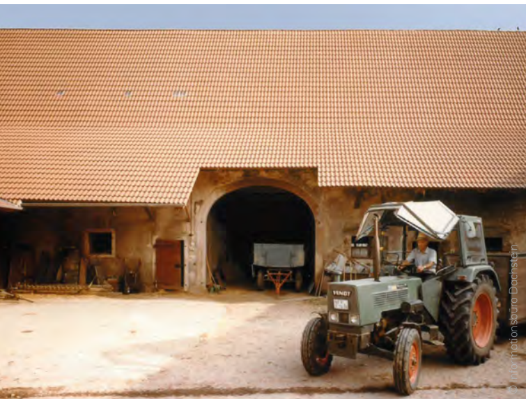
Beton-Dachsteine auf denkmalgeschütztem Bauernhof.
