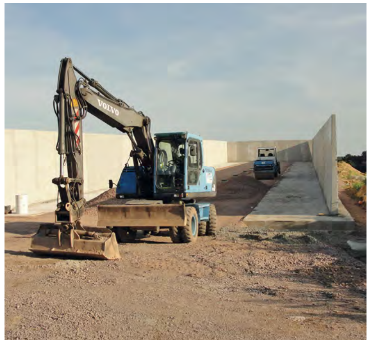
Fahrsilobau mit Fertigteilwänden.
