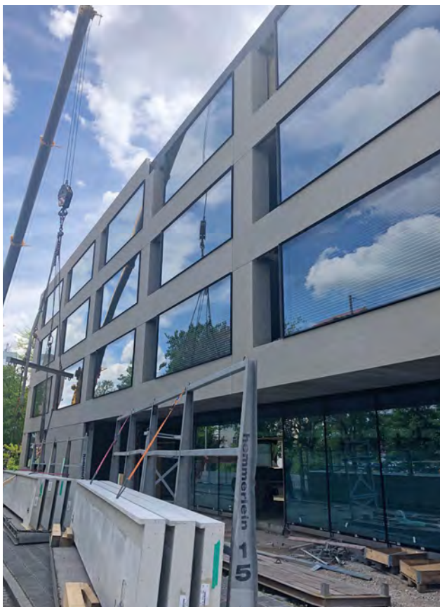
Fachgerechte Montage der Fassadenelemente durch Hemmerlein.
