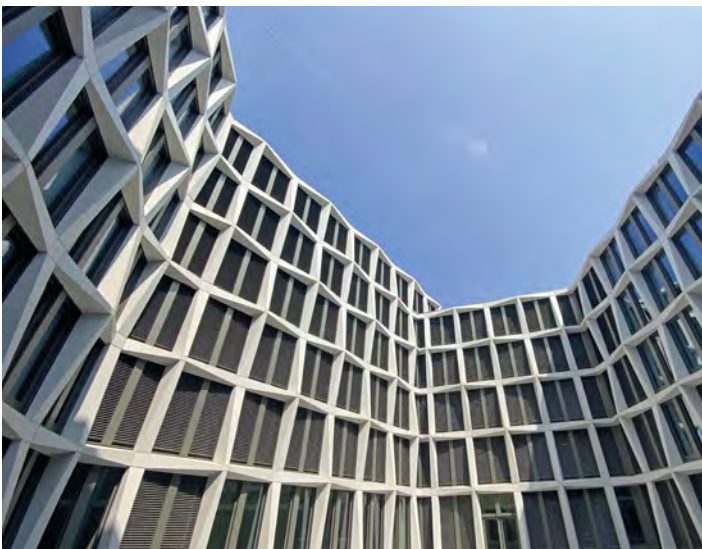
Bild 7: Architekturbetonfassade als lastabtragende Außenwand, BWE-Bau.
