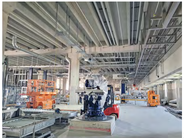
FT-Konstruktion der TT-Plattendecke und die Anlagentechnik in der Ausbauphase.
