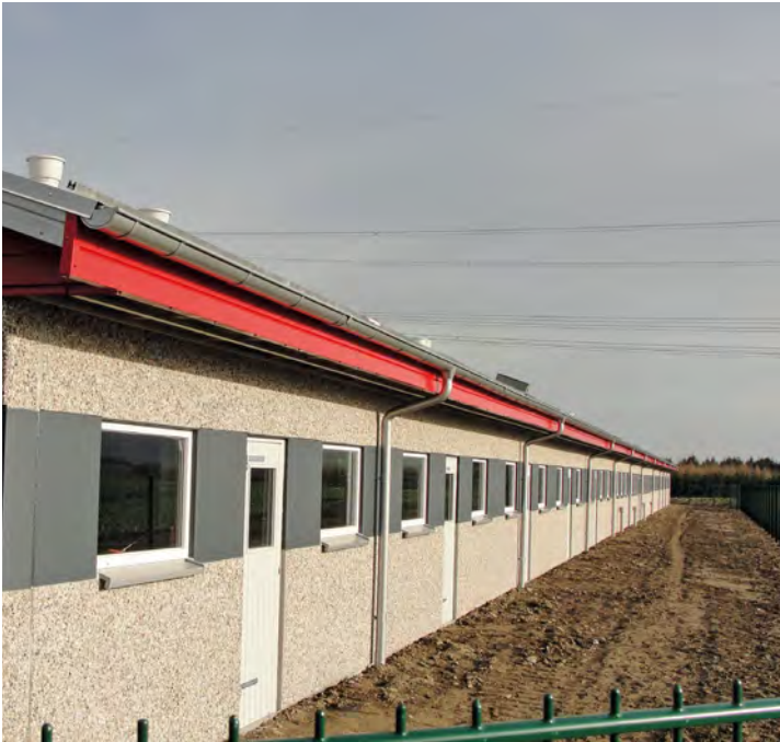
Schweinstall mit wärmedämmten Wandfertigteilen.
