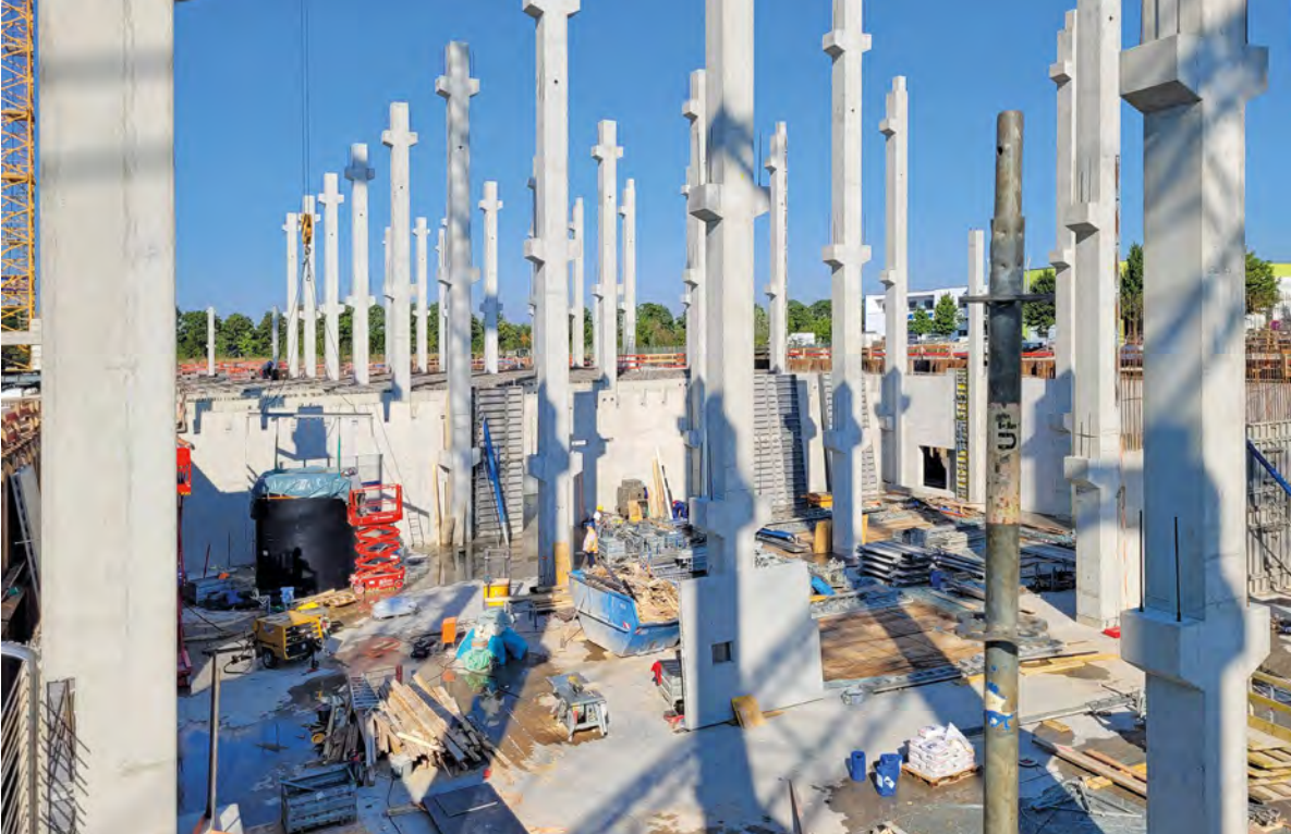
Letzter Abschnitt Stützen im KG, TT-Platten vorherige Montageabschnitte bereits verlegt.
