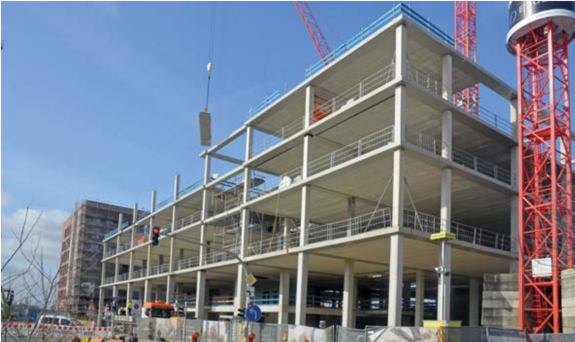
Just-in-time-Montage der Deckenelemente direkt vom Lkw.
