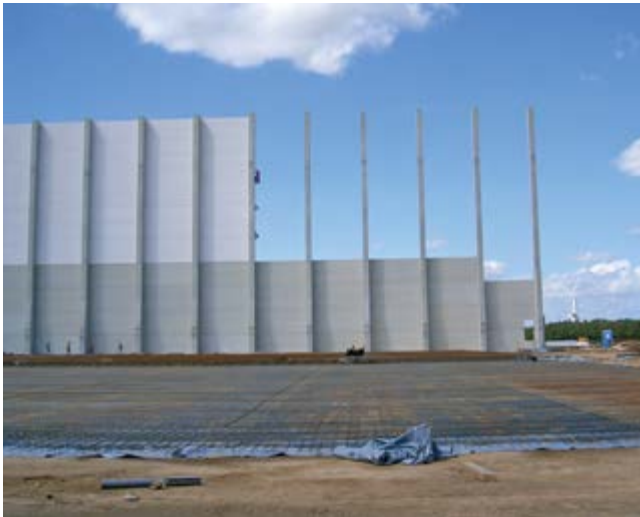
Beispiel: Hohe Halle – Logistikhalle mit 32 m hohen Stahlbetonfertigteilstützen.
