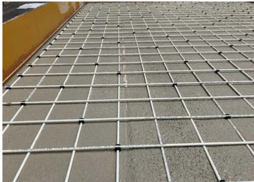
Herstellung dünner Sandwichfassadenelemente mit Glasfaser-Stabmatten im Fertigteilwerk Lehde.
