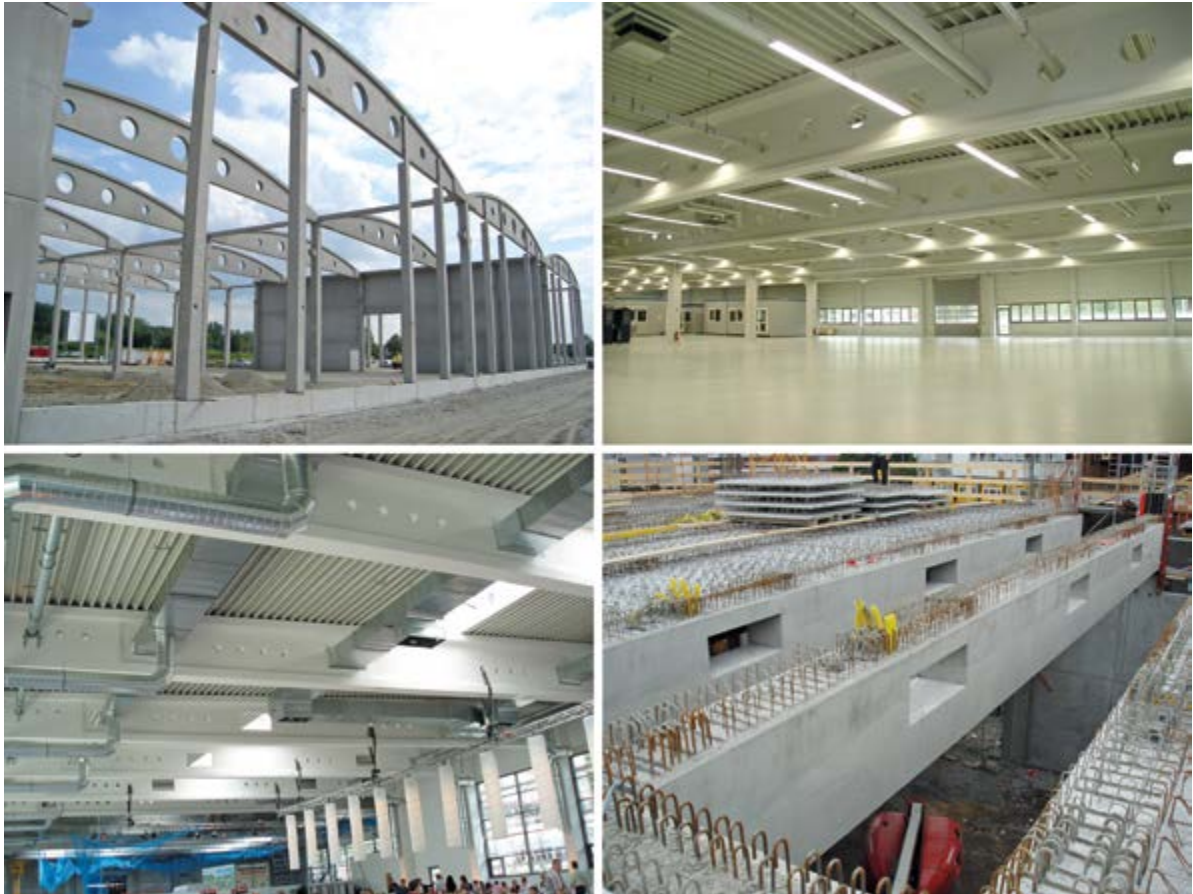
Fertigteilträger mit großen Aussparungen für Versorgungsleitungen.
