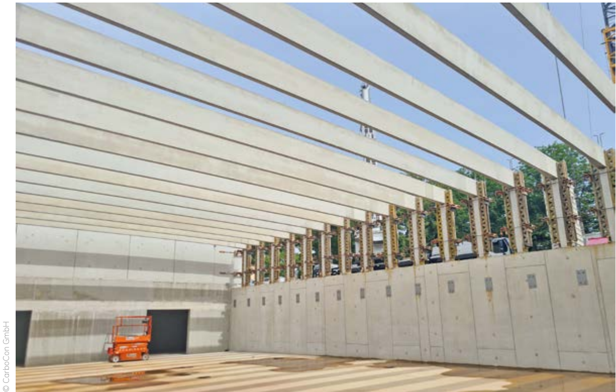
Turnhalle in Dresden: vorgespannte Carbonbetonbinder.
