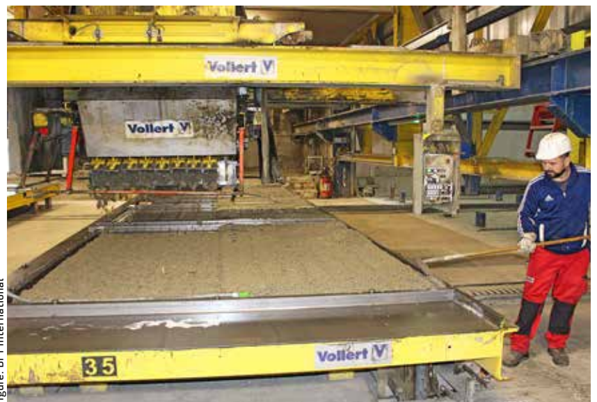
Blick in die Produktion, hier ein Betonverteiler aus dem Hause Vollert
