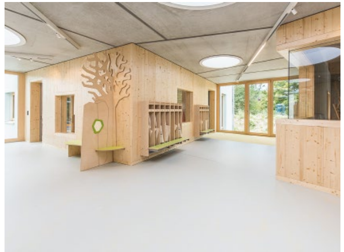
Bild 5. Deckenelemente mit hohem Anspruch an die Fugenausbildung infolge der unregelmäßigen Geometrie und Zusammenspiel zwischen Betonansichtsflächen und Holz (Fotos 4 und 5: Küffner, Rheinstetten)
