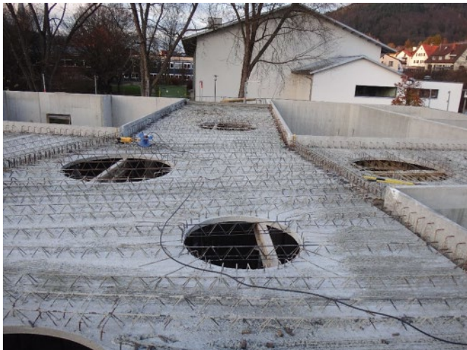
Bild 3. Elementdecken mit besonderer Anforderung an die Geometrie infolge Aussparungen und „schrägen“ Kantenverläufen (Grafik 1 und Foto 3: © MUNZArchitekt)
