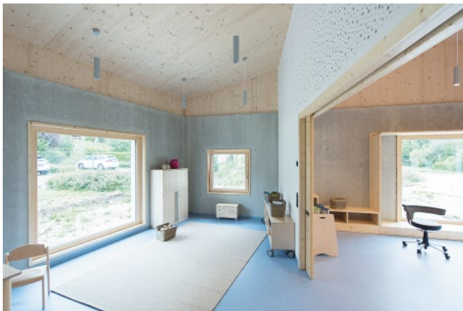
Bild 4. Doppelwände mit großen Öffnungen und Zusammenspiel zwischen Betonansichtsflächen und Holz
