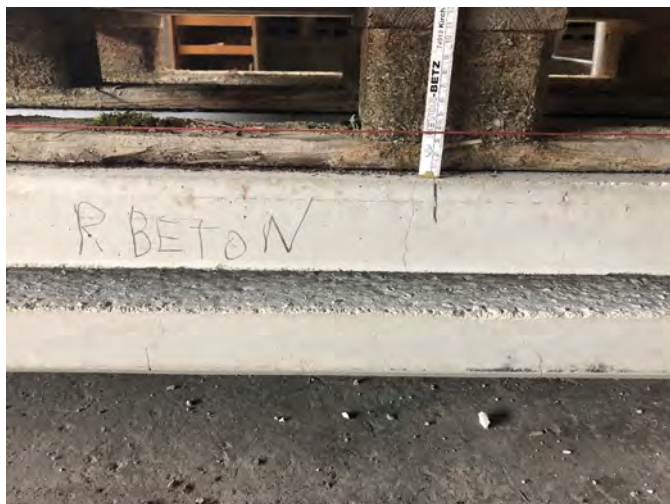
Bild 7 Prüfung zum Kriechverhalten: die in Feldmitte gemessene Durchbiegung nach 7 Wochen Dauerlast von 5 kN.
