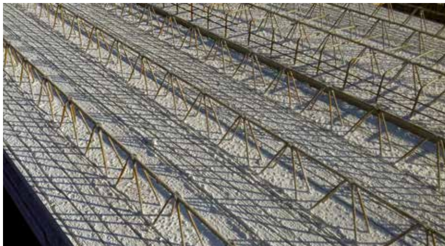
Elementdecke aus R-Beton mit Gitterträgern.
