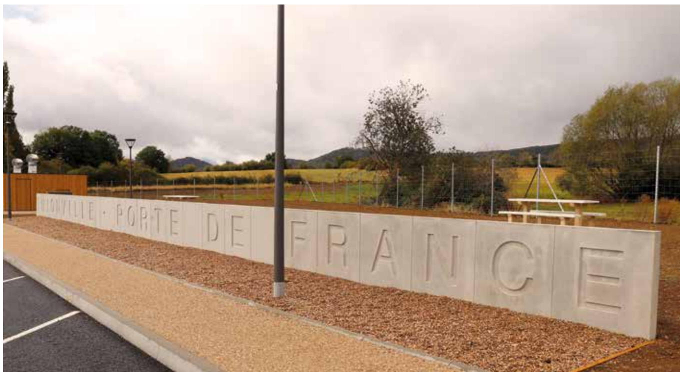
Ausgeführte Lärmschutzwand auf einem Rastplatz an der französischen Autobahn A 31 nahe Thionville Quelle: TU Kaiserslautern, Fachbereich Bauingenieurwesen, Fachgebiet Massivbau und Baukonstruktion
