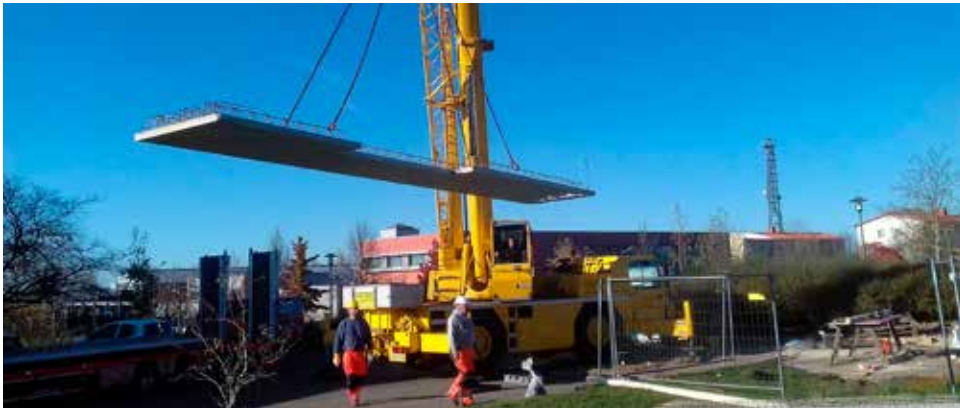
Unloading the precast concrete elements Entladung der Betonfertigteile
