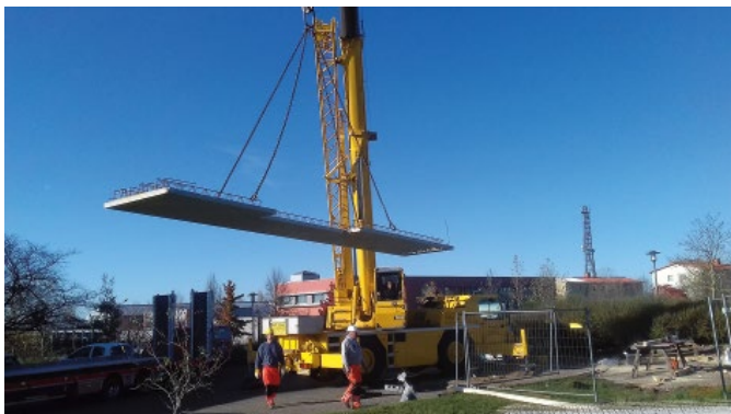
Bild 3. Entladung der Decken- und Wandelemente (Quelle: Ingenieurbüro Thiele Tragwerksplanung GmbH, Pirmasens)
