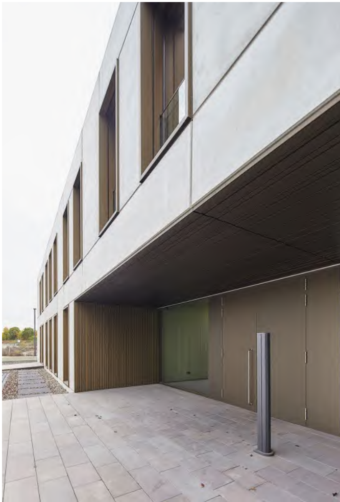
Bild 3. Betonfertigteile garantieren schnelles Bauen, Präzision und lange Nutzungsdauer. Durch die Kombination mit Aluminium konnte eine hochwertige langlebige Fassade aus Sichtbeton (Thermowand) realisiert werden. (Fotos: Matthias Schmidt)
