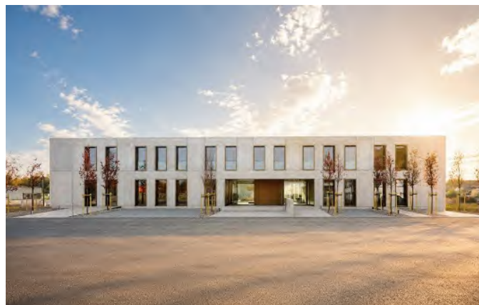
Bild 1. Gebäude aus automatisiert vorgefertigten Thermowänden in Sichtbeton. Und Klimadecken im Gebäude des Syspro-Gruppe Partnerwerk Andernacher Bimswerke GmbH & Co.KG (Architekten: PLANFAKTUR ARCHITEKTEN BDA Dipl.-Bauing. (FH) Nadine Bressler & Dipl.-Ing. (FH) Sven Letschert Architekt BDA PartGmbH, Montabaur) garantieren ein angenehmes Raumklima.
