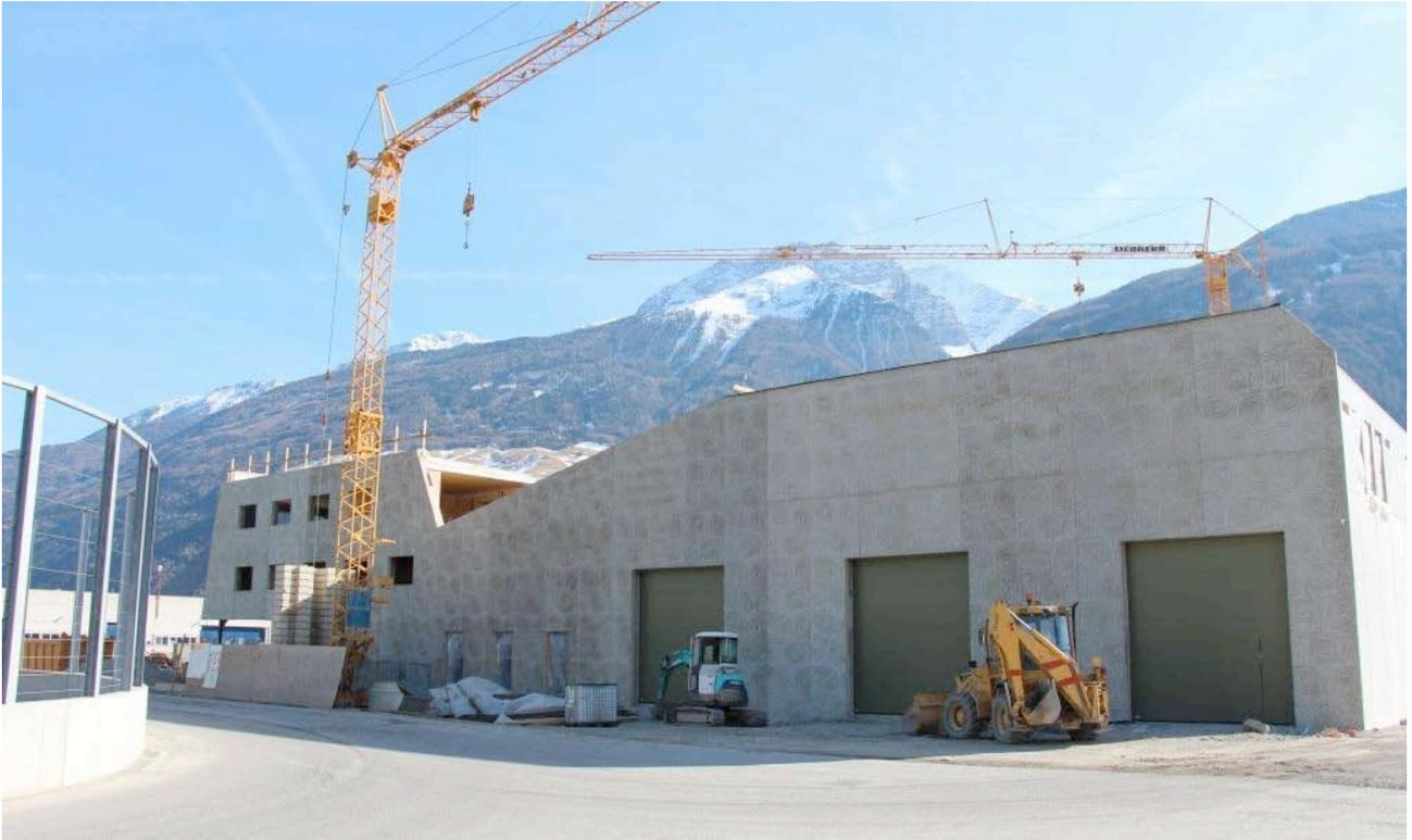
Die Thermowandelemente bestehen aus zwei geschosshohen Stahlbetonschalen mit integrierter Bewehrung und fertigen Oberflächen. Jede Thermowand ist ein Unikat mit individuellen Abmessungen und Aussparungen sowie Einbauteilen für den Ausbau.
