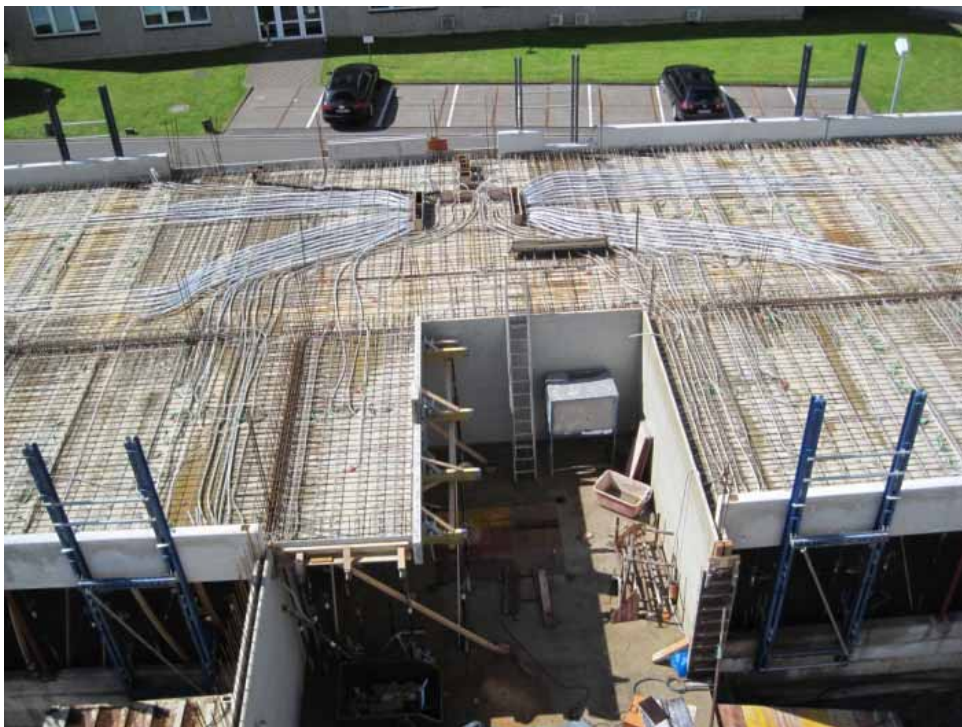
ZGM-Gebäude im Rohbau: Fertig verlegte Elementdecken mit integrierten Installationen. Foto: Uponor
