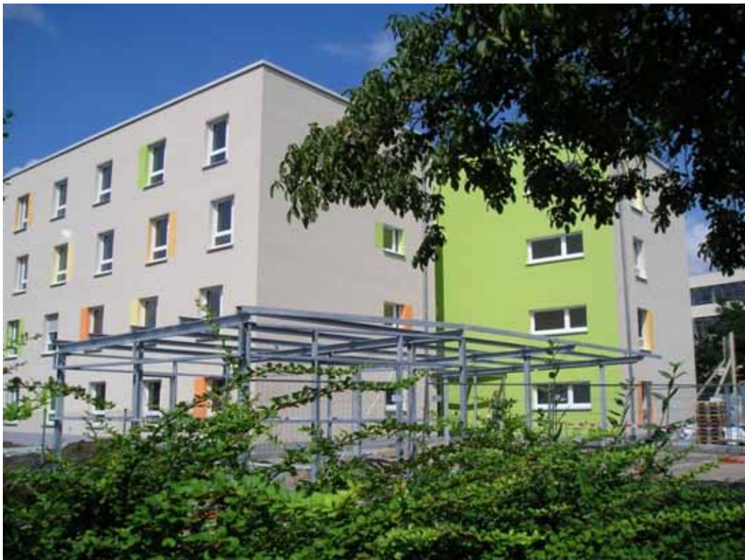
Ansicht des 2009/2010 errichteten Studentenwohnheims in Offenburg; Betonkernaktivierung mittels Wandheizung mit Verbundrohr.
