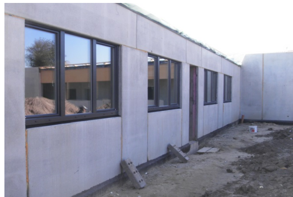
Thermowände tragen wesentlich zum zeitgemäßen Wärmeschutz des neuen Tierheims bei.
