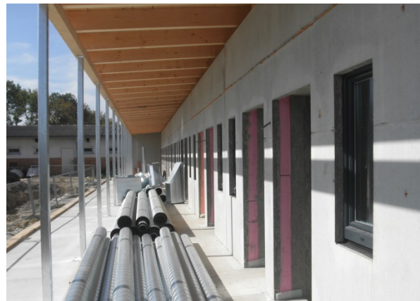
Thermowände tragen wesentlich zum zeitgemäßen Wärmeschutz des neuen Tierheims bei.
