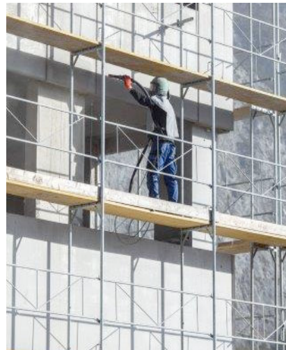
Die Oberflächen der Wandelemente der gesamten Gebäude-Außenseite werden in einem zweiten Schritt sandgestrahlt, um eine Struktur zu erhalten.
