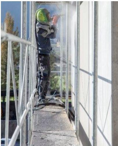
Die Oberflächen der Wandelemente der gesamten Gebäude-Außenseite werden in einem zweiten Schritt sandgestrahlt, um eine Struktur zu erhalten.
