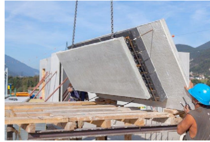
Wand mit anbetoniertem Fenstersturz beim Versetzen. Das Holzpodest sichert den Einbau ohne Beschädigung.
