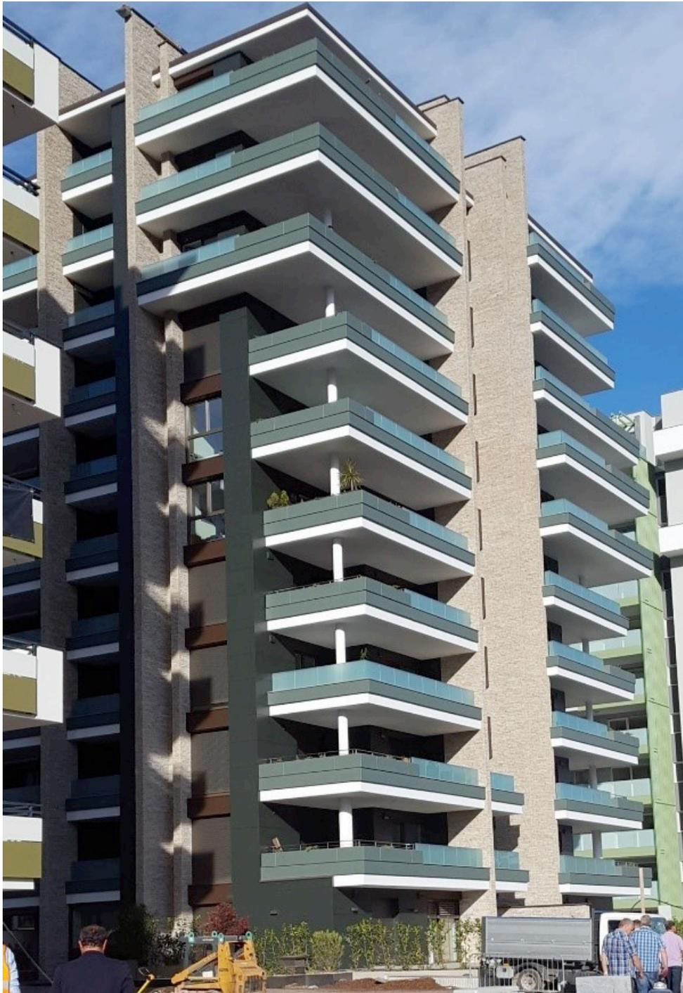
Das Wohnhochhaus in Bozen wurde mit Thermowänden und Klimadecken des Herstellers PROGRESS gefertigt. Vorgefertigte Thermowände und Klimadecken werden weit über die rein statische Funktion hinaus zur Steigerung von Wohnqualität und zur Optimierung der Energiebilanz genutzt. In den Betonfertigteilen mit innen liegender Dämmung sind Leerrohre oder Installationen ebenfalls integriert: für Elektro, Heizung und Kühlung, für Be- und Entlüftung. Bohr-, und Stemmarbeiten an fertigen Wänden entfallen.
