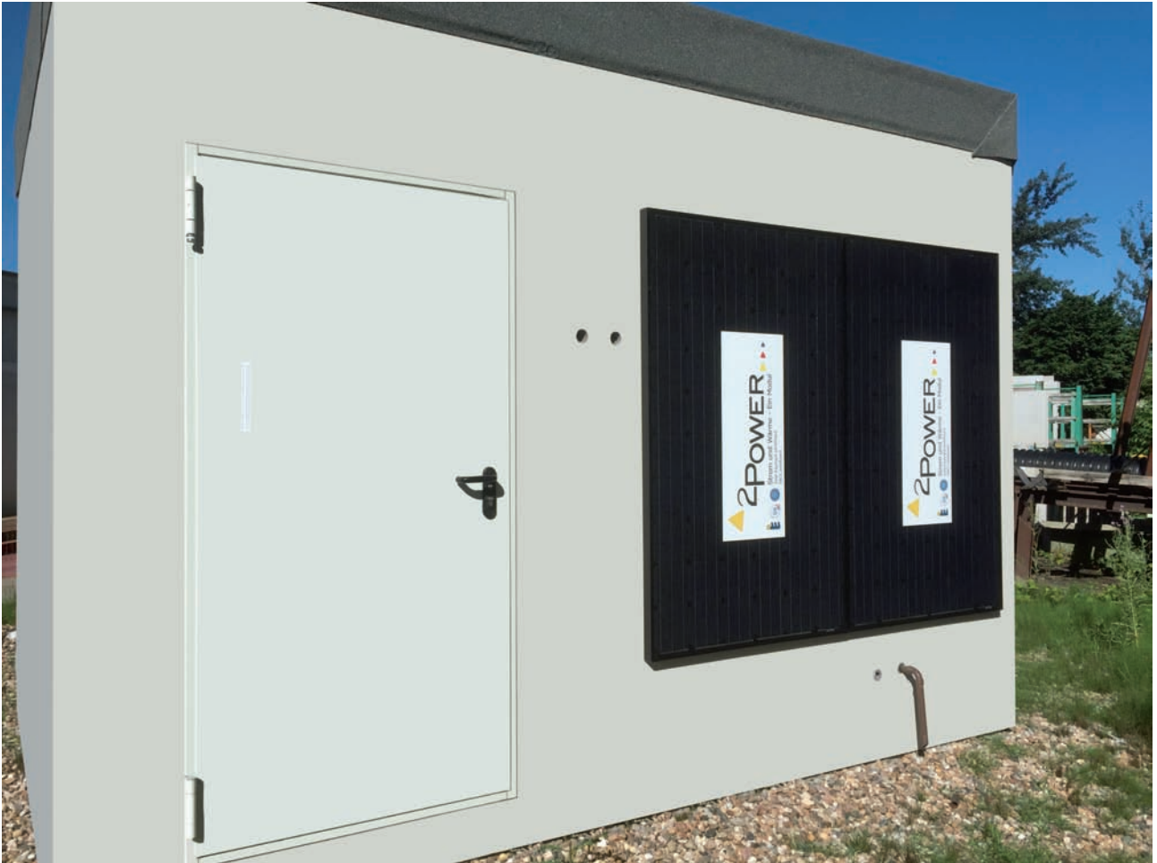
Kasko-Südansicht, also die aktivierte Betonfassade als solarer Massivabsorber ergänzt um 2 Photovoltaik-Module
