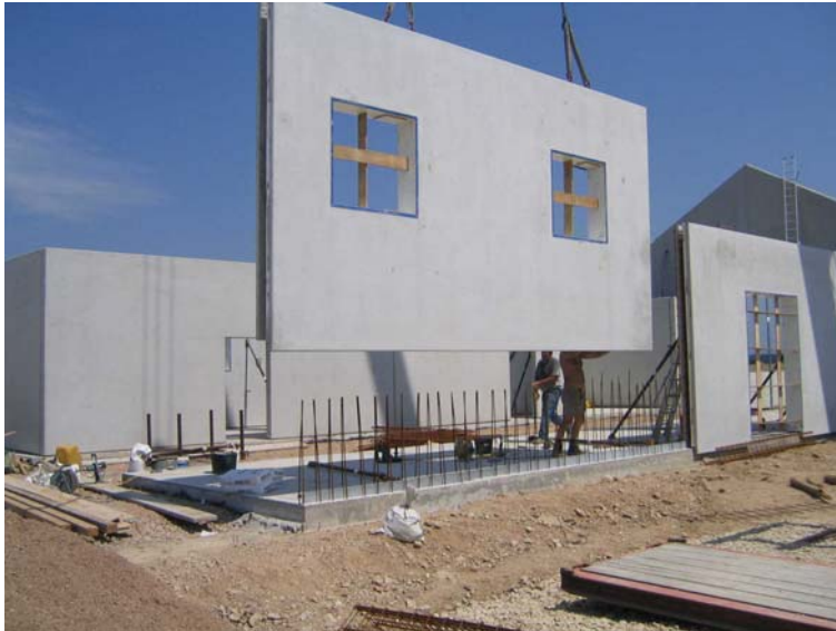
Montage eines Thermowandelements mit „Einfädeln“ in die Anschlussbewehrung der Bodenplatte.
