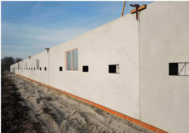
Eine glatte Außenwandfläche, saubere Fugen und ein ordentlicher Fundamentanschluss kennzeichnen die Bauweise.
