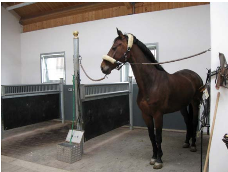
Qualitätsstall aus Betonbauteilen – sauber und sicher, mit „trittfesten“ Wandoberflächen.
