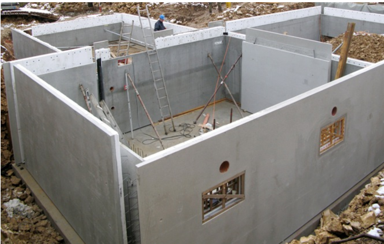
WU-Keller aus Thermowandelementen.
