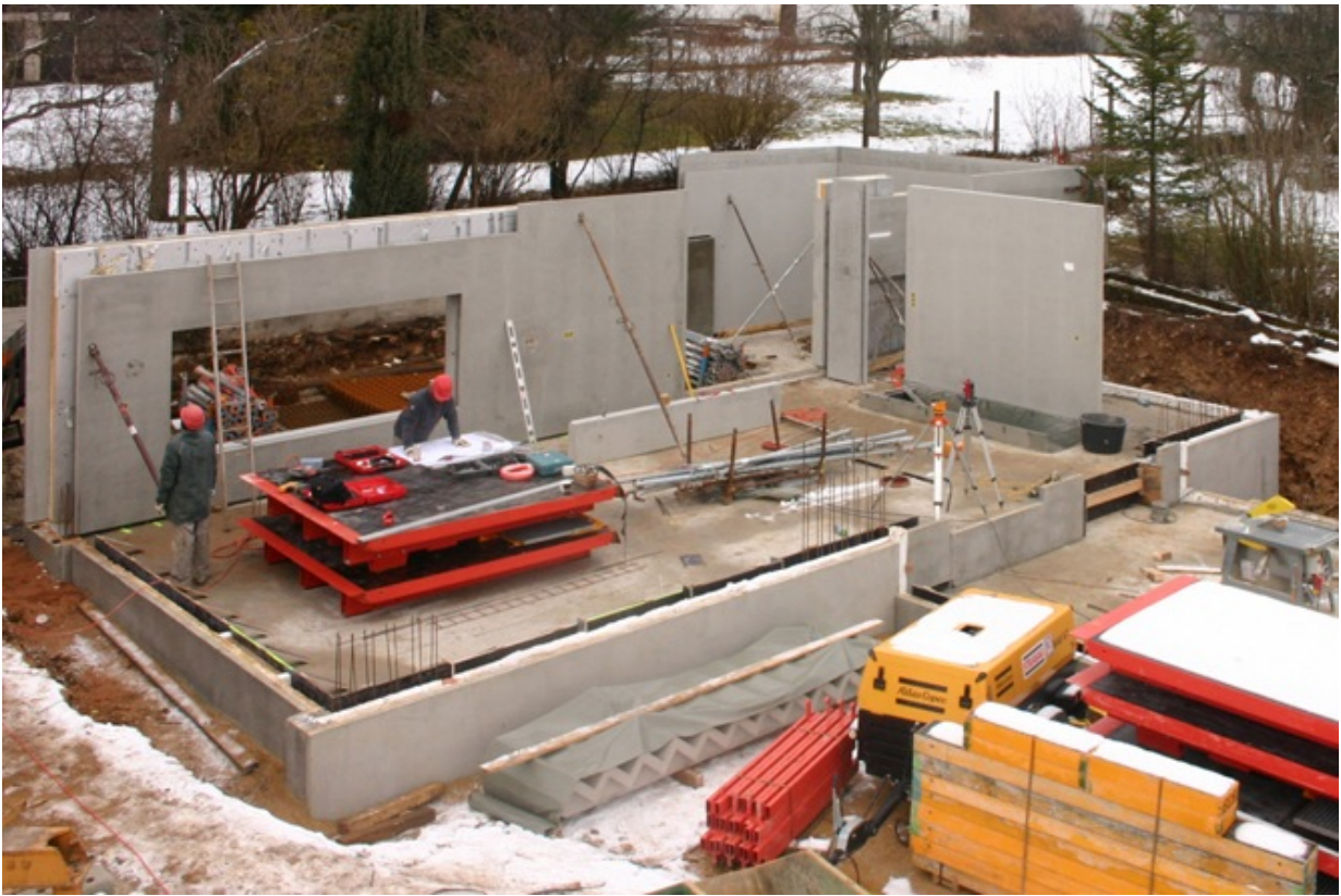
Montage der Wandelemente für das Erdgeschoss.
