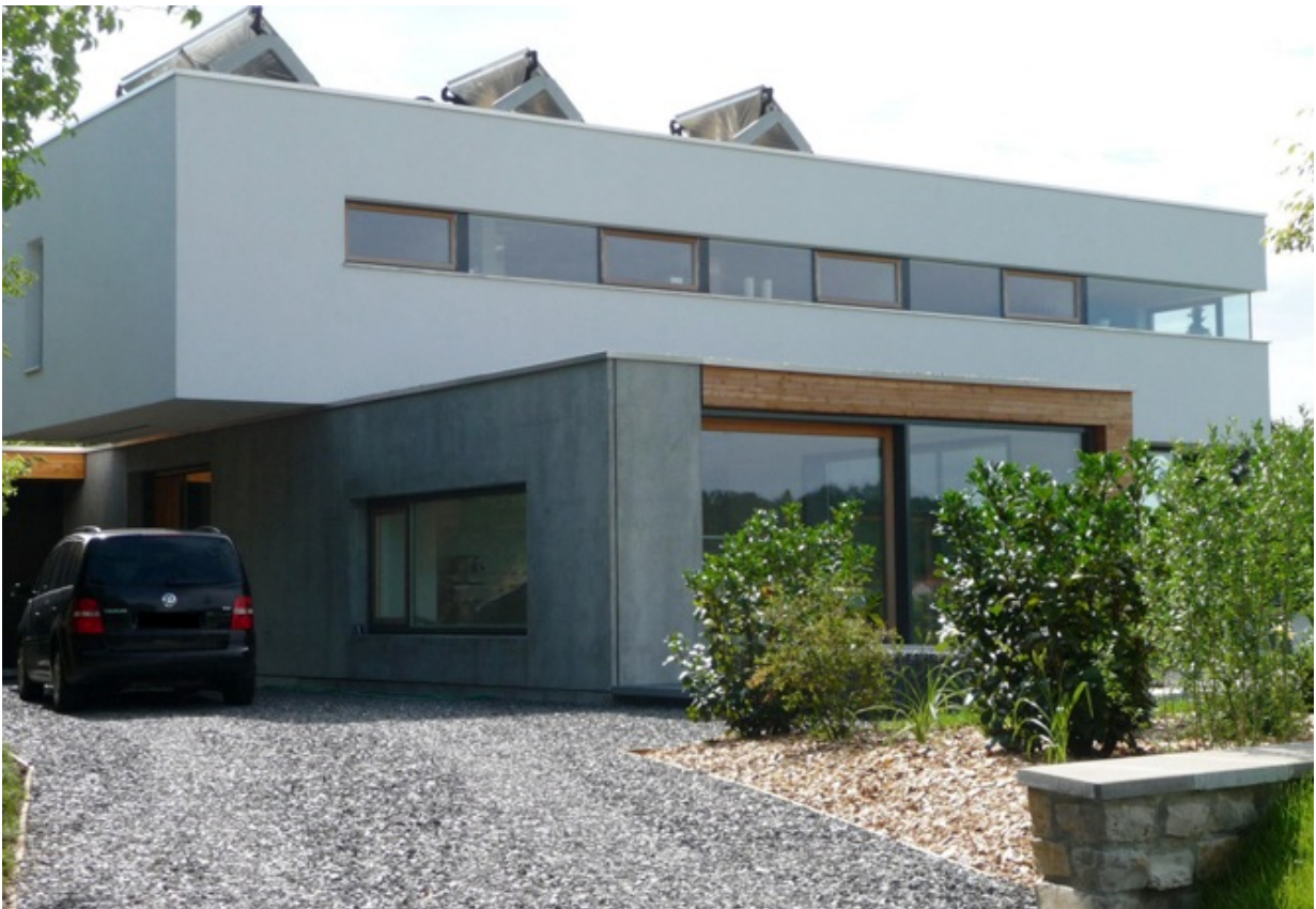
Die Auskragungen des Obergeschosses und das lange Fensterband verlangten eine intensive Abstimmung mit dem Statiker. Auf dem Dach: Eine Solaranlage.
