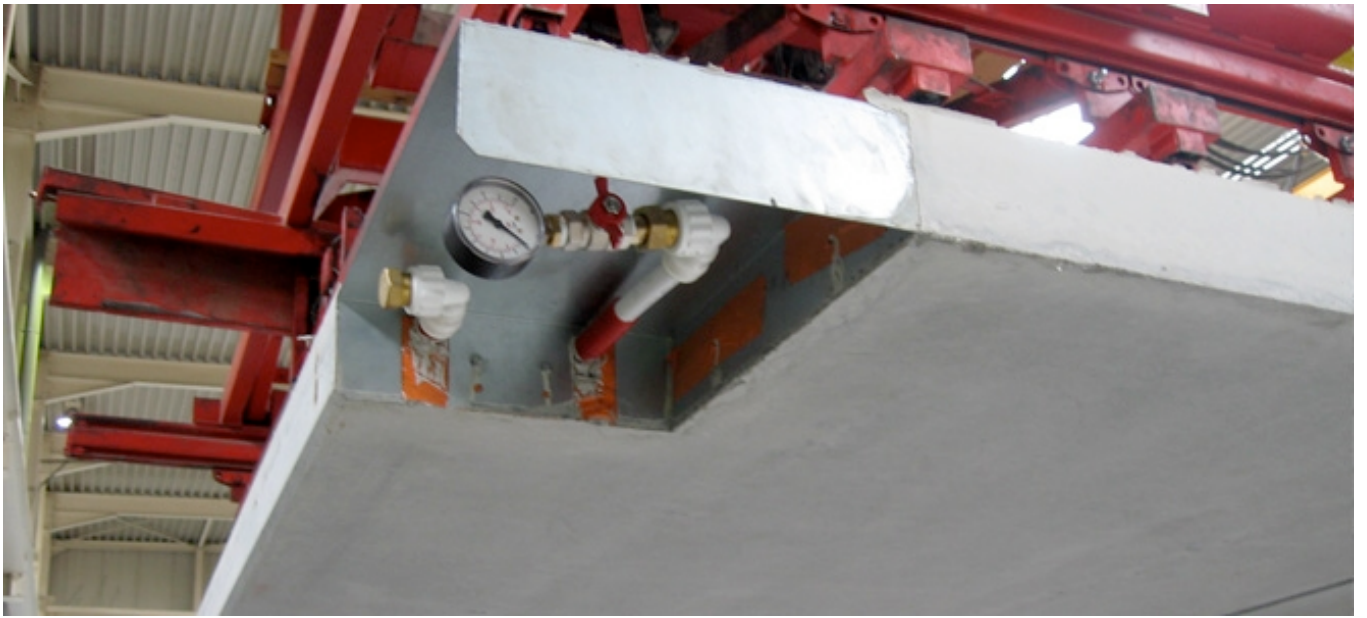
2011 entwickelt: Die Activ-Decke mit Betonkernaktivierung.
